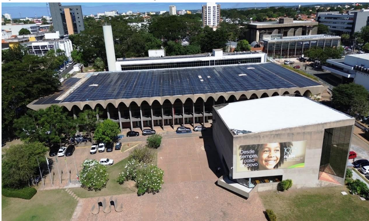
Figura 02 – Vista aérea da Assembleia Legislativa do Estado do Piauí.
